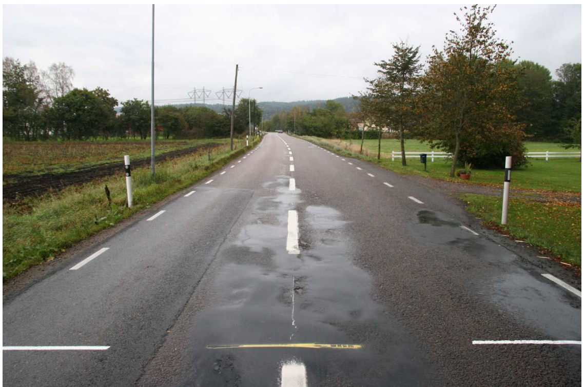
Figur 2.2 Exempel på partier med gjutasfalt
